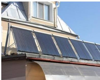
Рис. 2. Группа солнечных коллекторов для энергообеспечения жилого дома (расположение - крыша)
