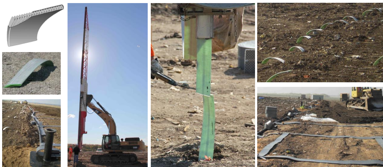
Рис. 11. Сооружение систем дегазации по технологии Multriwell на полигоне ТКО «Преображенка» (г. Самара, 2012 г.)
